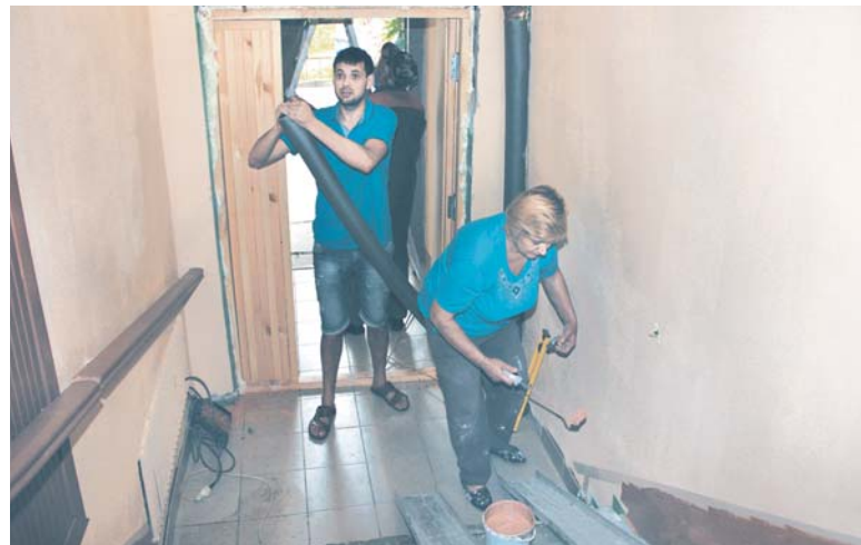
Ремонт подъезда в д. 2, корп. 3 на ул 1-й Крестьянской
