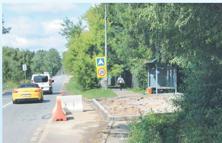
На территории, подведомственной «ТУ «Федоскино», проводится ремонт автобусных остановок
