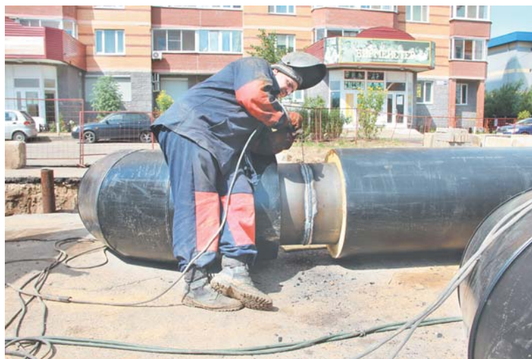
На ул. Юбилейной, у д. 40 идет капитальный ремонт магистральных сетей
