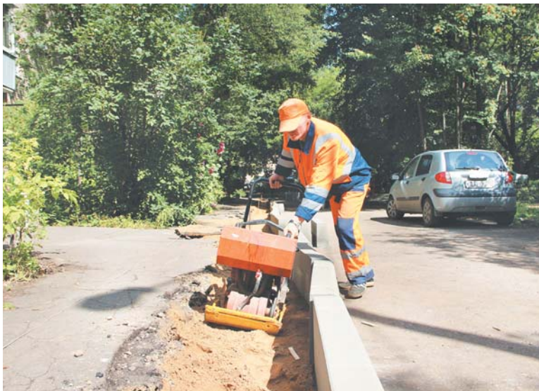
Ремонт дороги на ул. Индустриальной, д. 15
