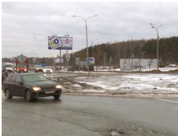
Окончание всех работ на пересечении улиц Мира и Борисовки запланировано в июне
