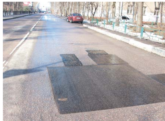
Все дефекты дороги на ул. Сукромке устранены
