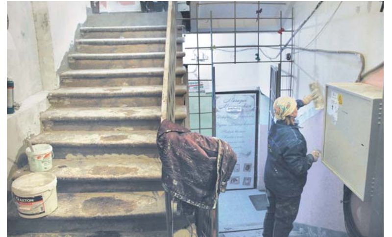
Ремонт подъезда в доме 4 на улице Колпакова
