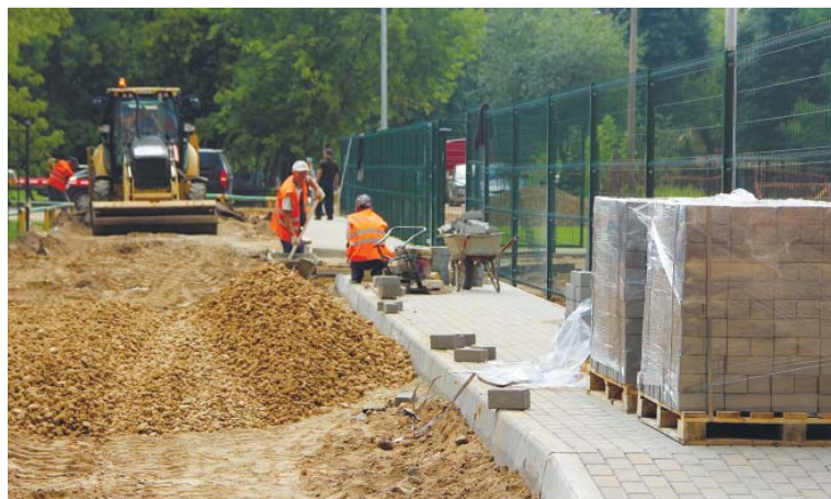
На ул. 3-й Крестьянской рядом с новым детским садом ведутся работы по ремонту внутриквартального проезда
