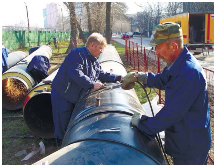
Специалисты ОАО «Мытищинская теплосеть» ведут плановые работы по подготовке теплоэнергетического оборудования к началу нового отопительного сезона
