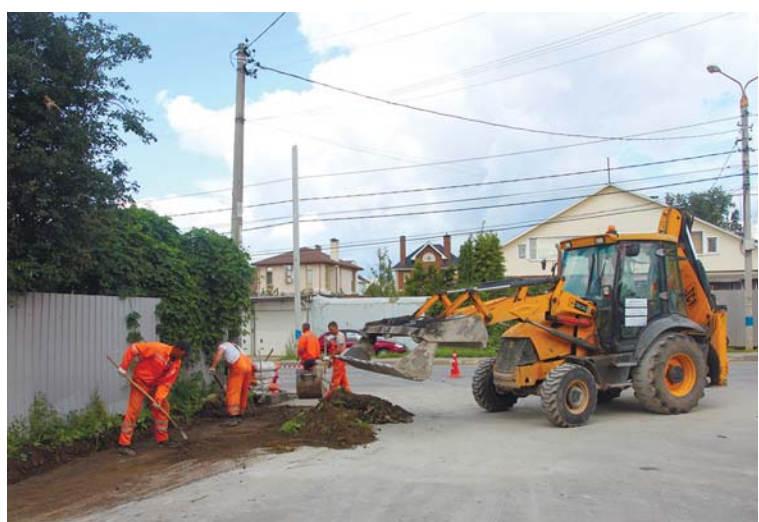
В деревне Вешки идут работы по строительству тротуара рядом с автобусной остановкой на ул. Центральной
