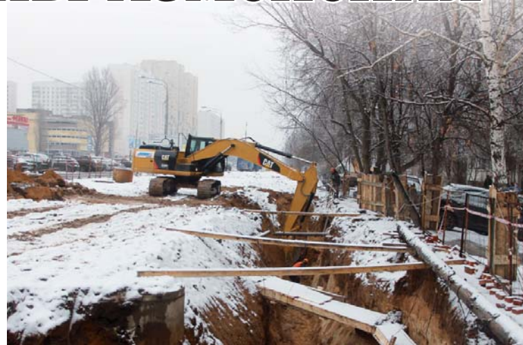
В настоящее время на улице Юбилейной ведется прокладка труб и коммуникаций
