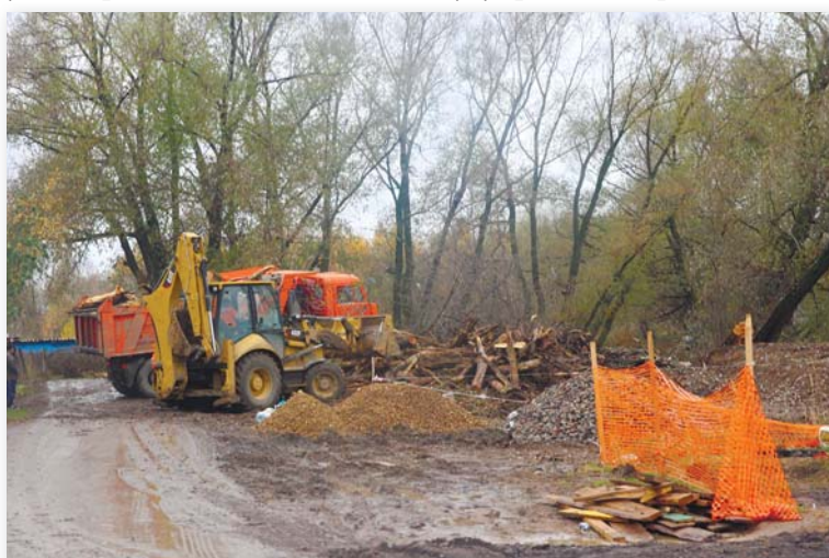
Кроме очистки водоема проводится и санитарная вырубка деревьев
