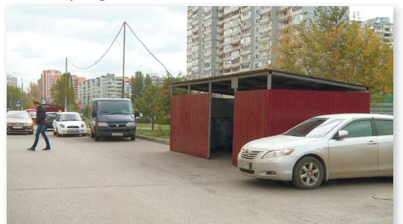
Вот такие крытые контейнерные площадки появились в 15-м и 16-м микрорайонах
