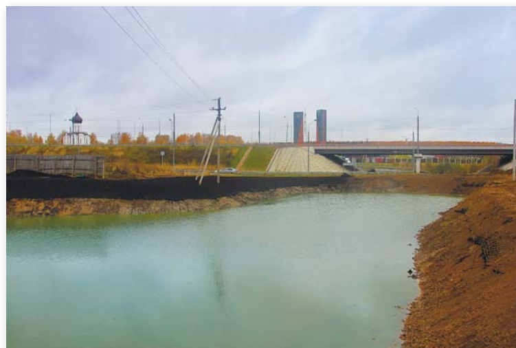
Пожарный водоем в деревне Бородино практически готов
