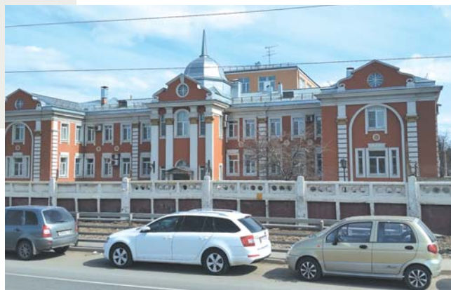
Административное здание бывшего военного завода №88 (ныне РКК «Энергия»)
