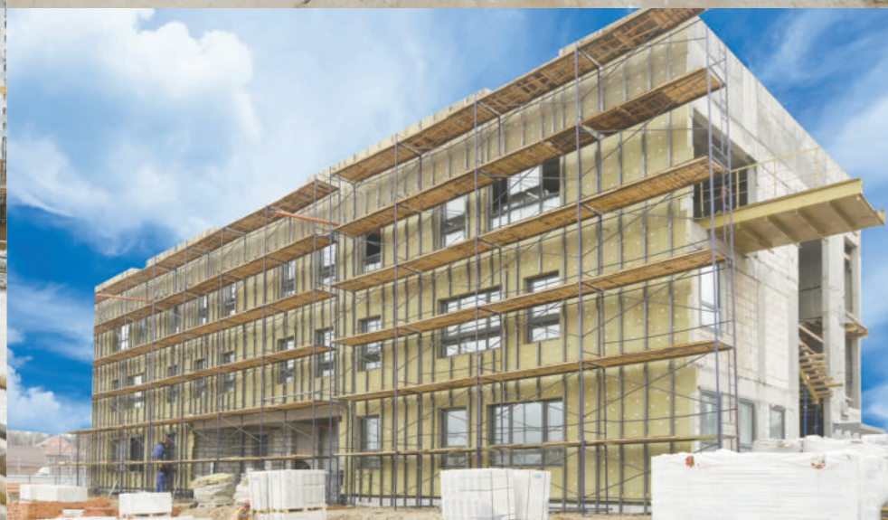
Строительство детского сада на 320 мест восточнее д. Погорелки
