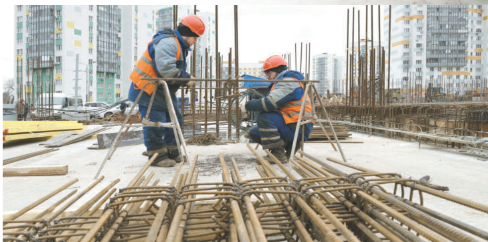
Строительство образовательной школы на 1100 мест в микрорайоне 25А
