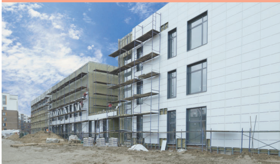
Строительство образовательной школы на 1100 мест восточнее д. Погорелки
