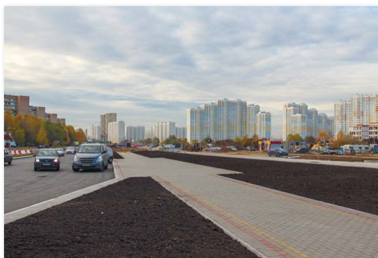
Реконструкция ул. Юбилейной идет полным ходом
