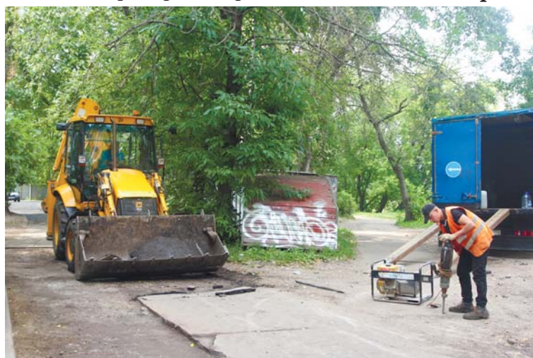
В минувшие дни ямочный ремонт проводили на улице 1-й Крестьянской, д. 2, корп. 1, 2, 3
