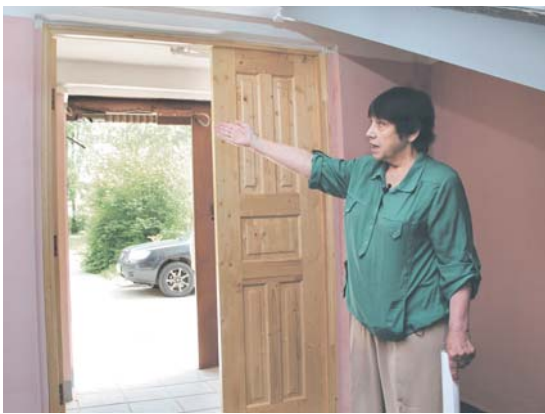
В доме №10 по ул. Щербакова при ремонте подъездов заменили все входные группы
