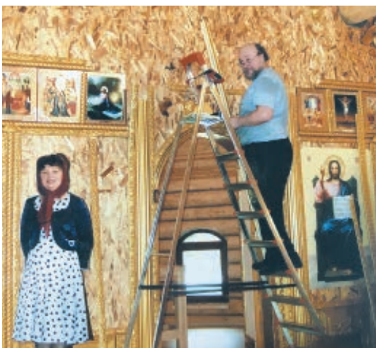
Строительство алтаря храма Александра Невского. Сергей и Татьяна Рыжковы
