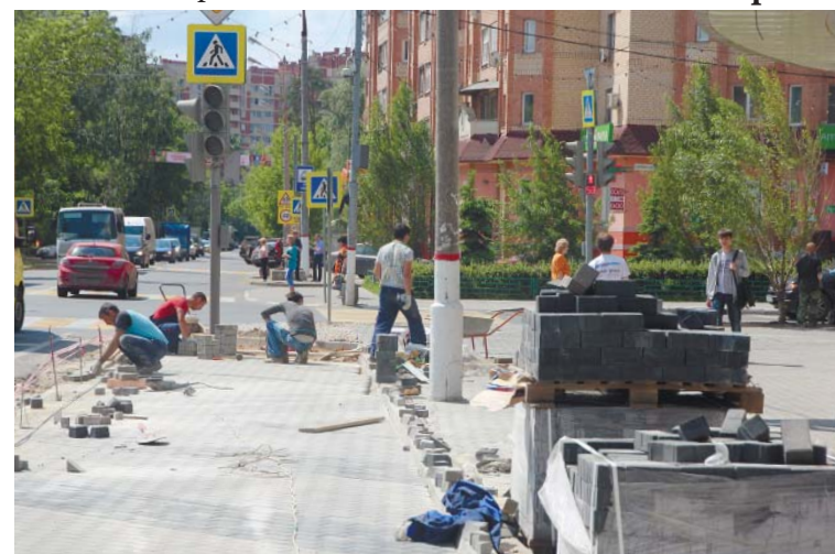
На улице Семашко ведется строительство тротуаров
