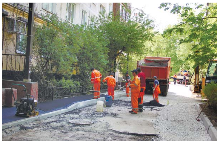
На данный момент ведутся работы по восстановлению тротуарной плитки на улице 1-й Крестьянской
