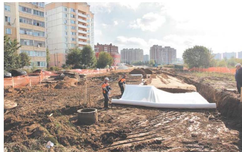
Строительство автодороги от Юбилейной на Благовещенскую улицу идет полным ходом
