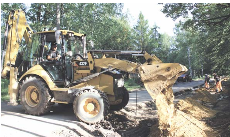
Улицу Широкую в д. Беляниново расширяют до пяти метров
