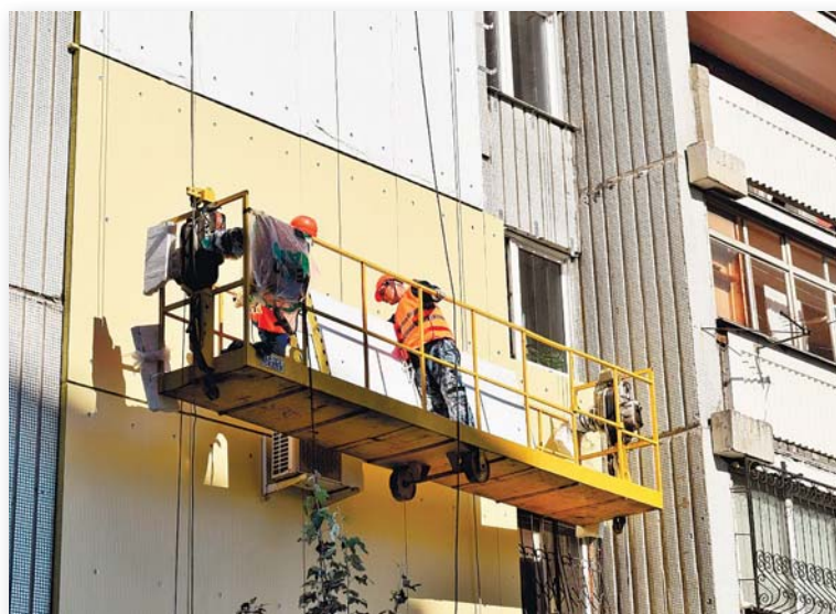
Утепление д. 3 по ул. Воровского производится по технологии, которая пользуется высоким спросом в суровом сибирском климате
