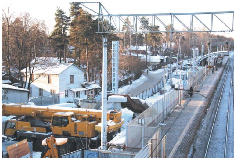
Работы по удлинению железнодорожного моста в районе станции Тайнинской продолжаются
