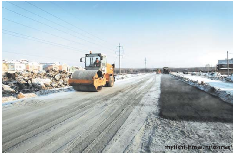
Некоторое время назад работы на трассе автодороги Д. Ульяновко – Осташковское шоссе были приостановлены
