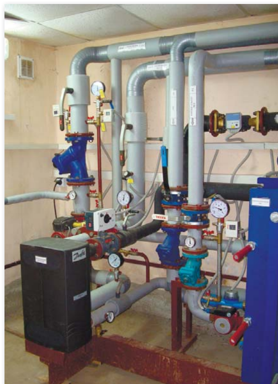
Внедрение индивидуальных тепловых пунктов позволяет снизить объем потребления тепловой энергии
