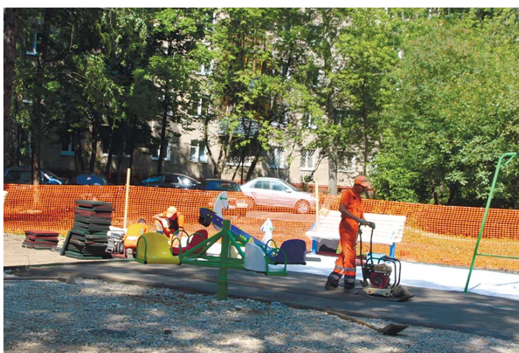
На Новомытищинском проспекте, д. 82, корп. 3, 4 идут работы по благоустройству двора
