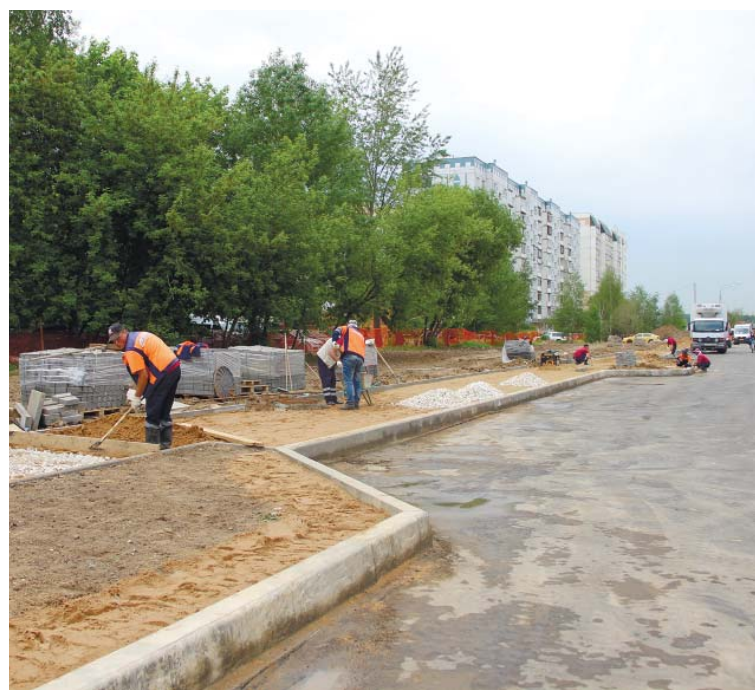
Срок завершения ремонтных работ по ул. Юбилейной назначен на конец июня
