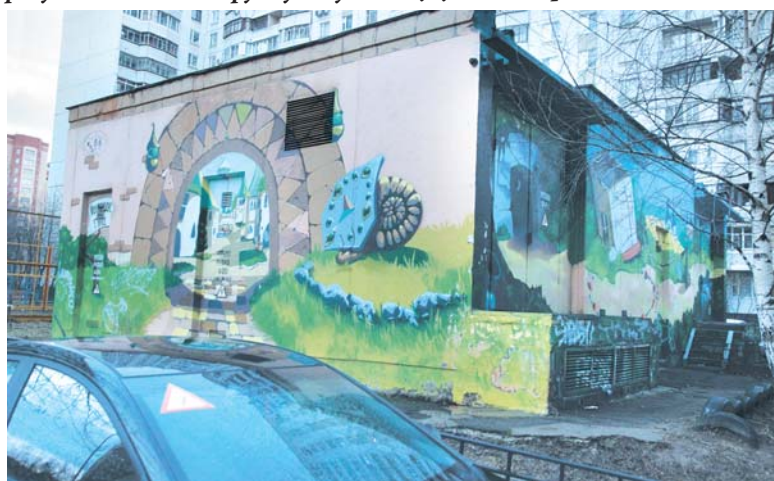
Персонажи Льюиса Кэрролла на трансформаторной подстанции в конце Новомытищинского проспекта
